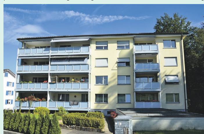
Fenstersanierung von 1a hunkeler fenster AG mit 60 neuen TOP-WIN-Fenstern.
